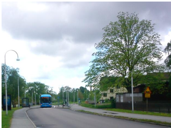
Teknisk anläggning, nätstation
